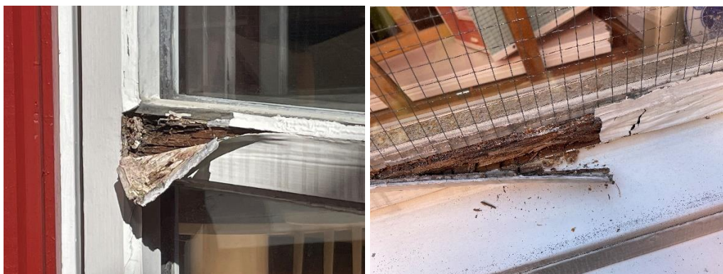
Exempel där virket är rötskadat.
